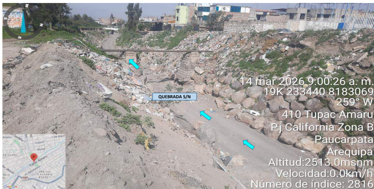
IMAGEN 02: EN ESTE TRAMO SE OBSERVA EN AMBAS MÁRGENES DE LA QUEBRADA S/N, SE ENCUENTRA CON ROCA SUELTA EN SU TALUD, SIN PROTECCIÓN EN DICHAS MÁRGENES.
